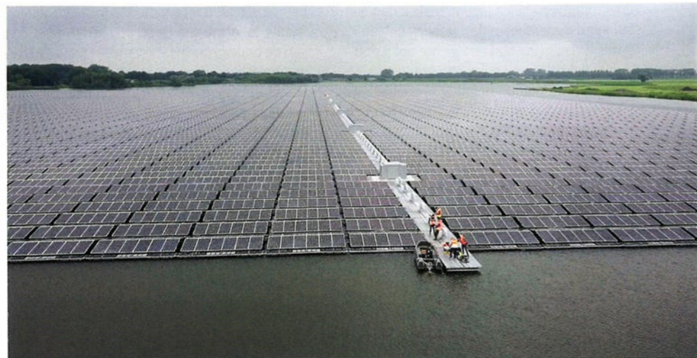
Beeld van het drijvend zonnepark op de Bomhofplas. Aangemeerd ligt de boot met apparatuur voor monitoring.
